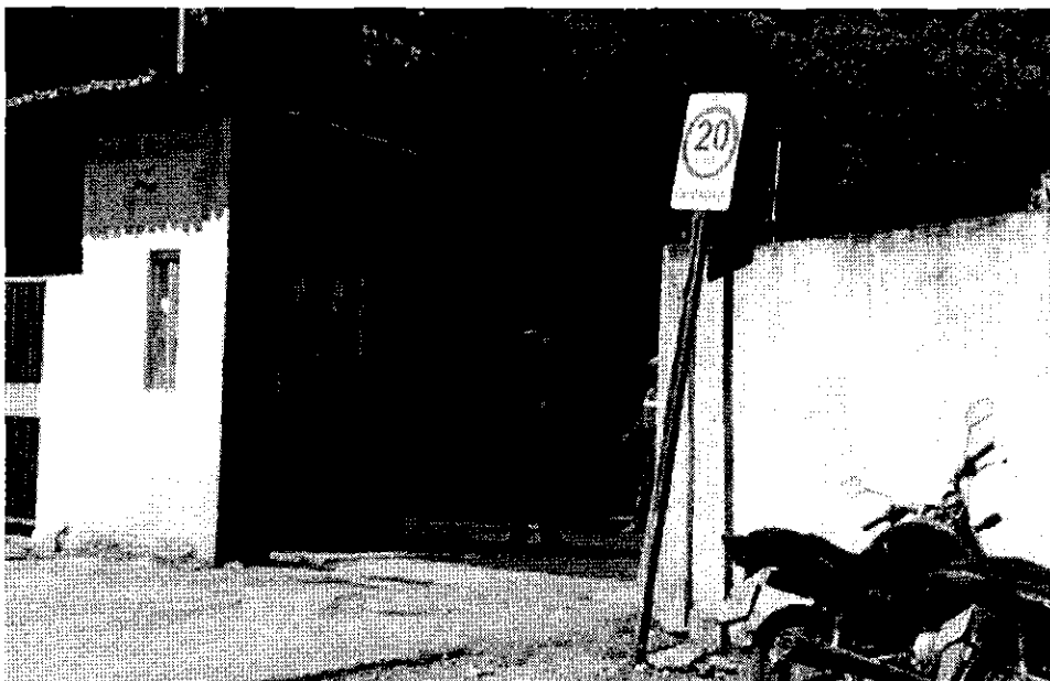
Foto 6 - Guarita inadequada/ Cerca elétrica danificada.
