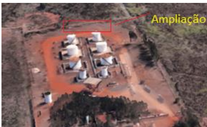
Figura 2 – Vista do local da ampliação
