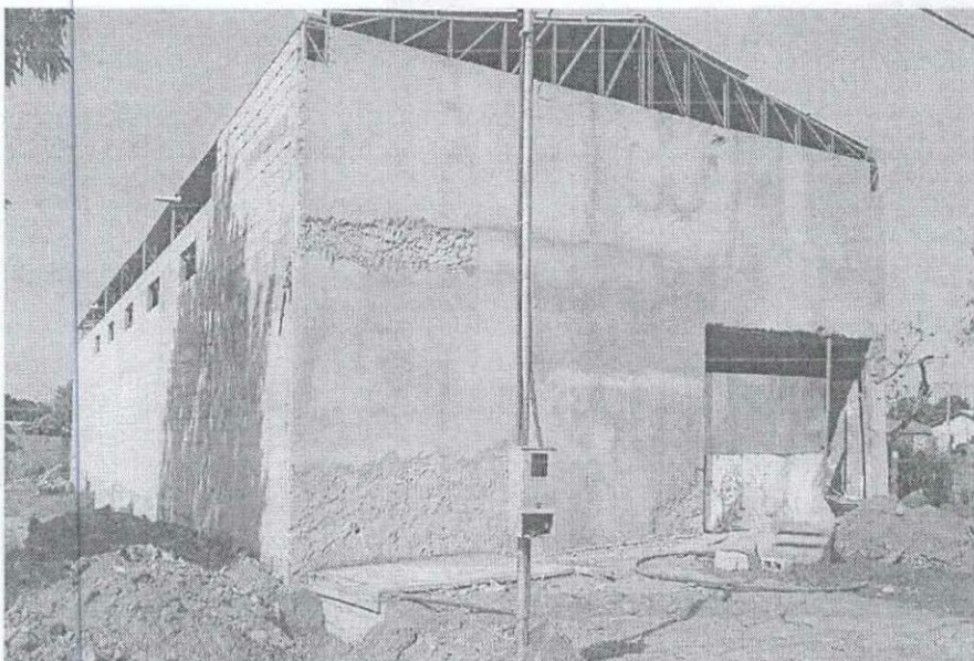
FOTO 08: Alvenaria de bloco estrutural com canaletas, vigas aéreas, com lajes na parte frontal da igreja:
