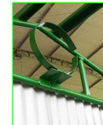
Imagem ilustrativa Base e arco para fixação do reservatório
