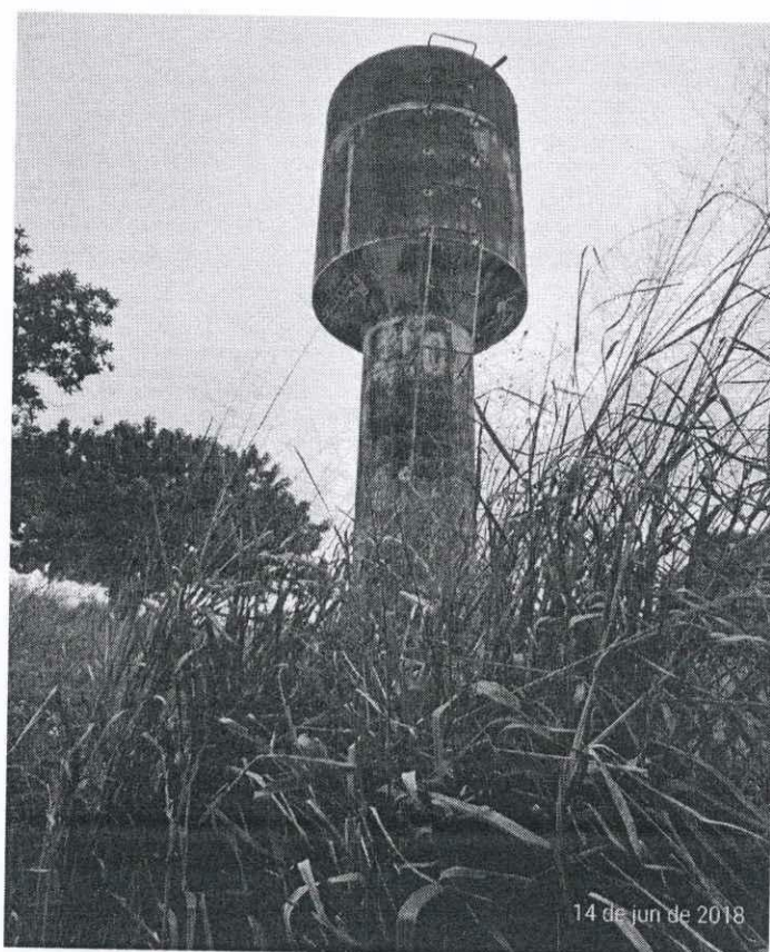
CAIXA D'AGUA EXISTENTE
