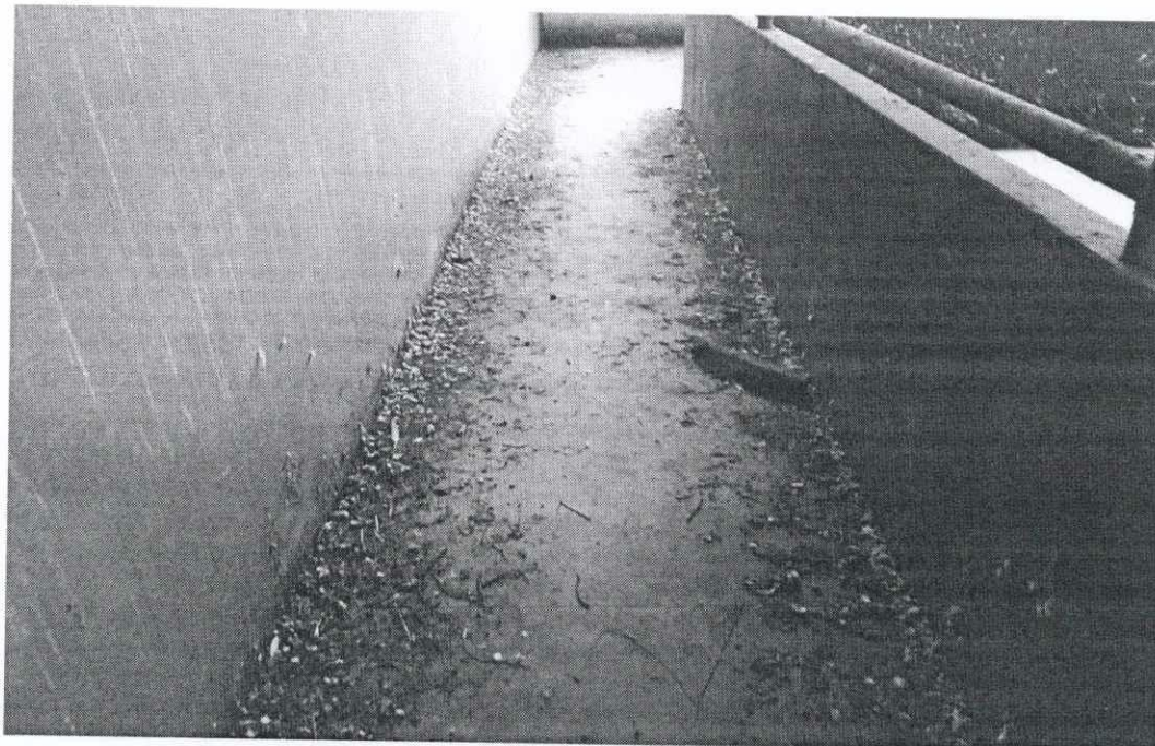
FOTO 01 - PISO EM TORNO DA QUADRA
