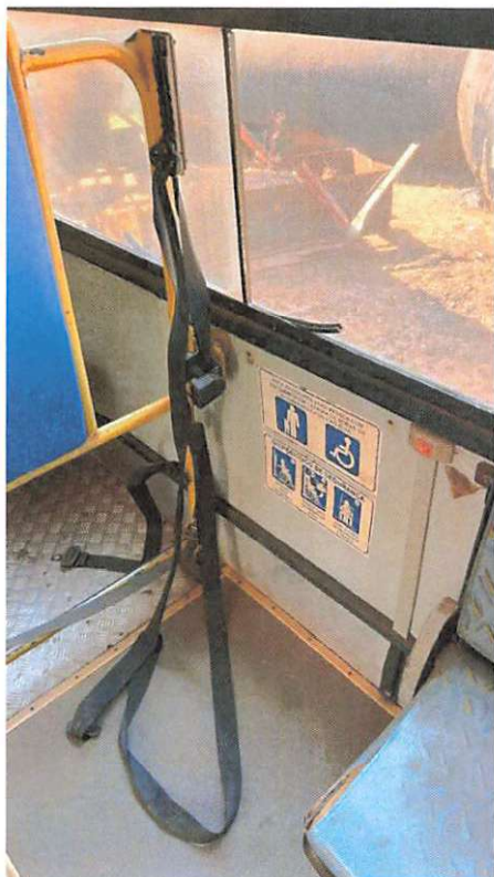
Imagem 11 – Rampa em condições precárias
