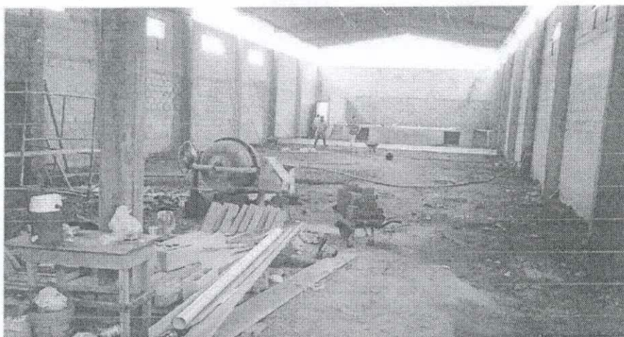
FOTO 02: Os mesmos pilares de estrutura metálica agora com reforço, com vigas aéreas em blocos de canaletas, com aço CA 50, concretados sob a minha responsabilidade:
