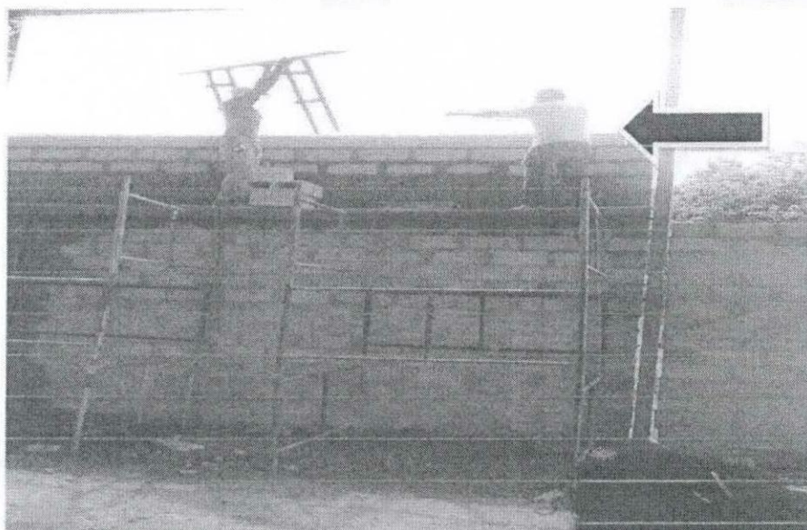
FOTO 06: Fechamento das paredes com bloco com fixação dos requadros das janelas, sob minha orientação:
