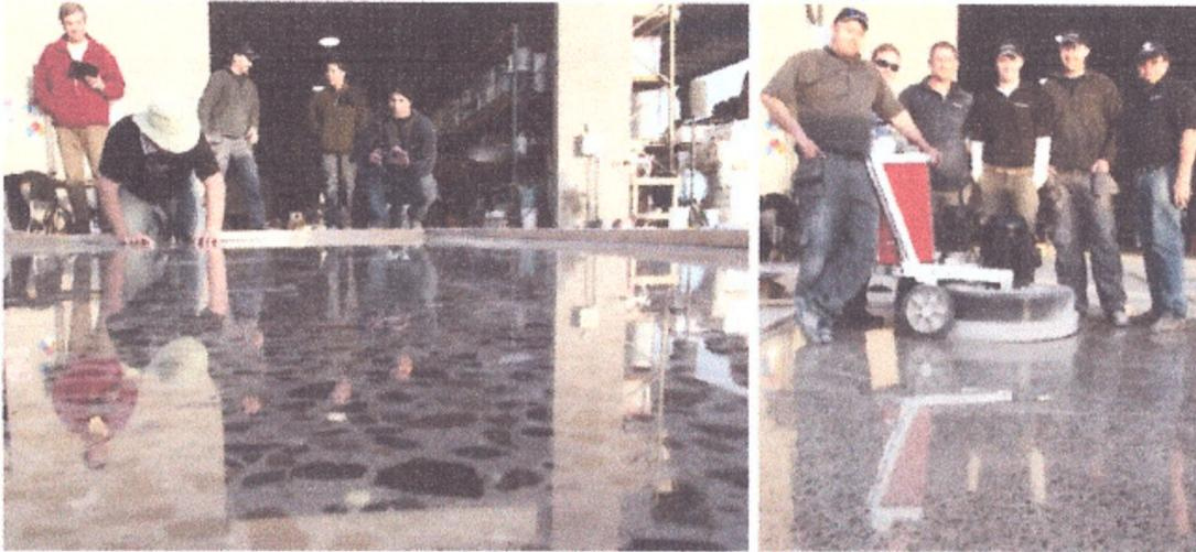
O concreto polido é um dos resultados do trabalho de desbaste e polimento realizado na superfície do piso, realizado por meio de politrizes de última geração e discos diamantados especiais para a função.
