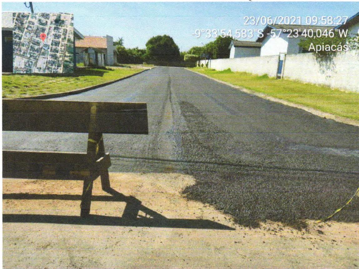
FOTO 36: MICRORREVESTIMENTO NA RUA PEQUENO PRINCIPE.
