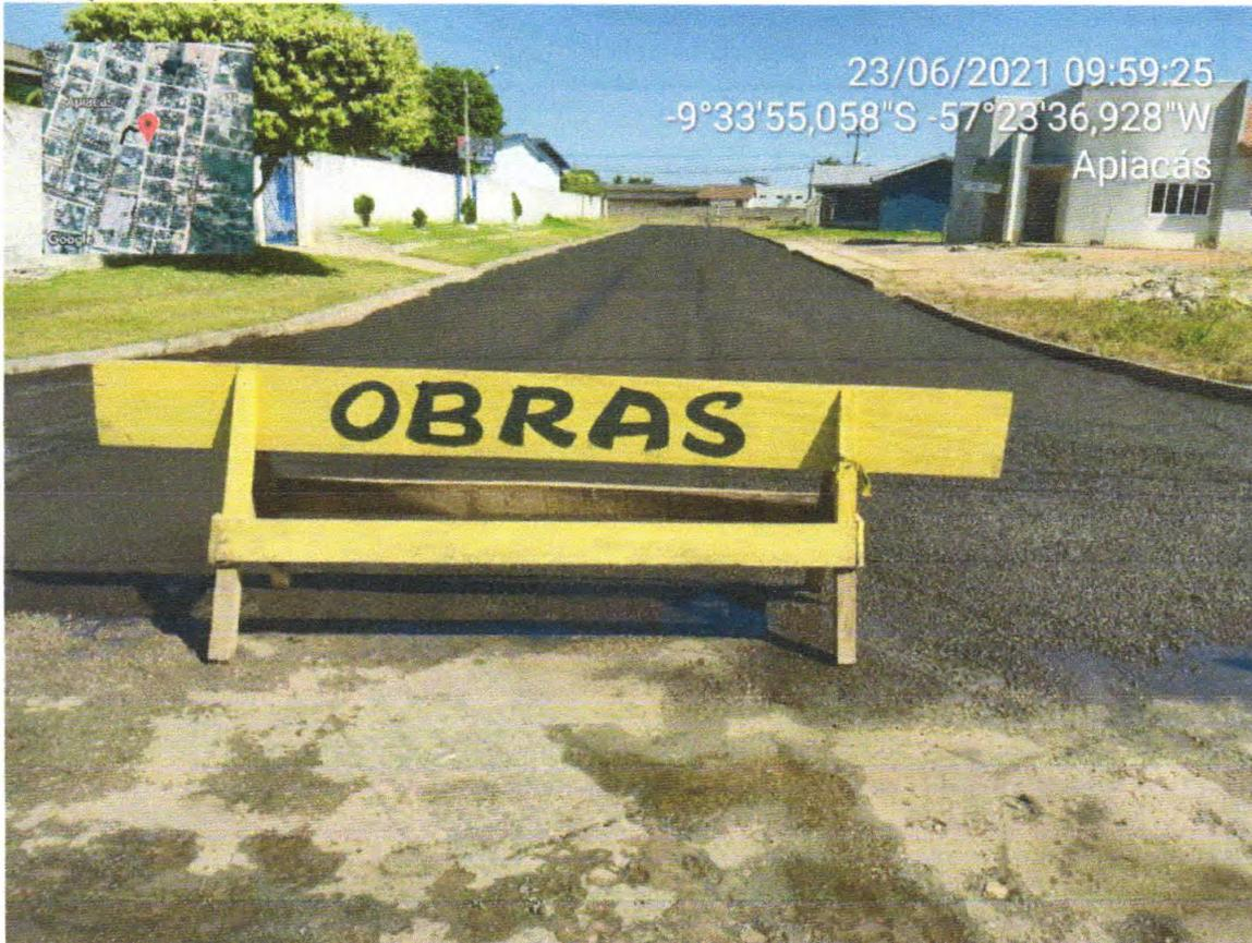
FOTO 35: MICRORREVESTIMENTO NA RUA PEQUENO PRINCIPE.
