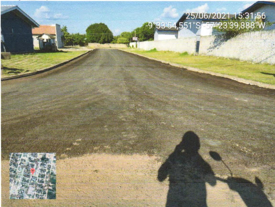
FOTO 19: MICRORREVESTIMENTO NA RUA PEQUENO PRINCIPE.
