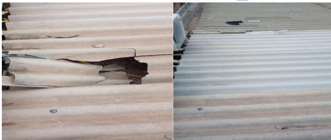
Reparo do telhado
